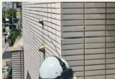
打診検査は、建物や構造物の内部状態を確認するための非破壊検査方法の一つです。この検査では専用の器具を用いて対象物の表面を軽く叩き、その音の反響を聞くことで内部の異常を検出します。
